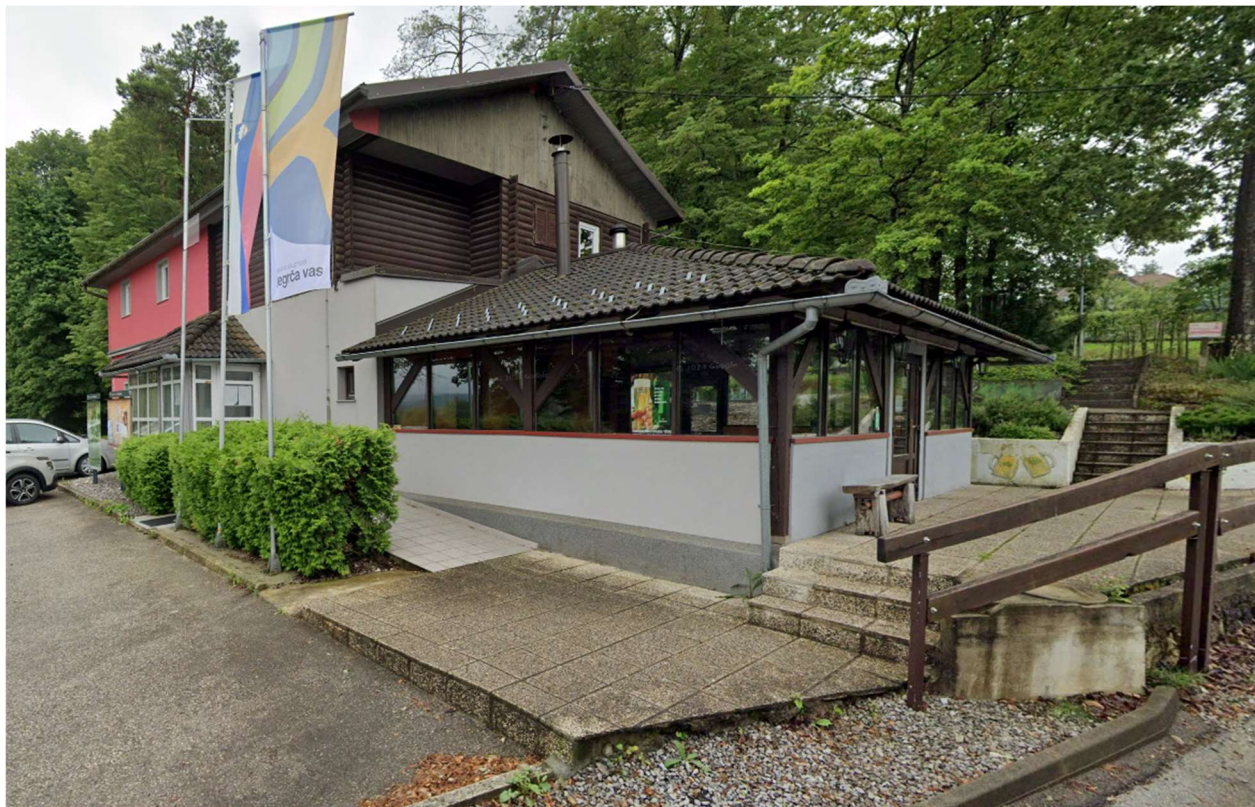
Slika 45: Pogled na objekt s pokrito gostinsko teraso.
