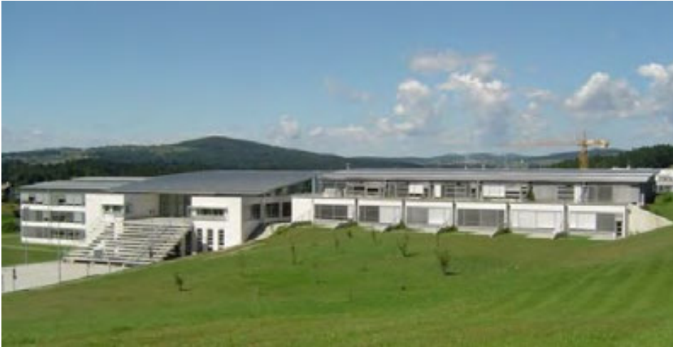
Slika 3: Obstoječi objekt Osnovne šole in vrtca Drska na območju OPPN
