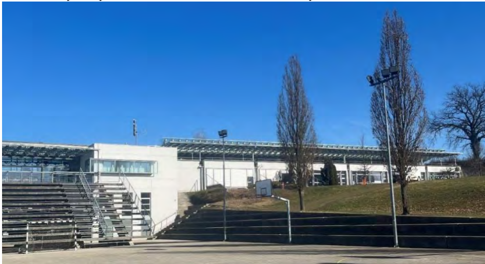
Slika 4: Obstoječi objekt Osnovne šole in vrtca Drska na območju OPPN
