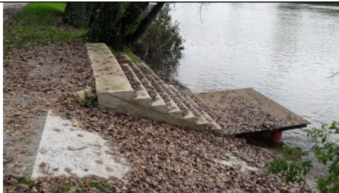
Slika 7: Obstoječe že izvedene ureditve za čolnarno (stopnišče in ploščad za spust čolnov v vodo). Predvidena je le še gradnja nadstrešnice. (foto: Kovač. M. 6.10.2017)
