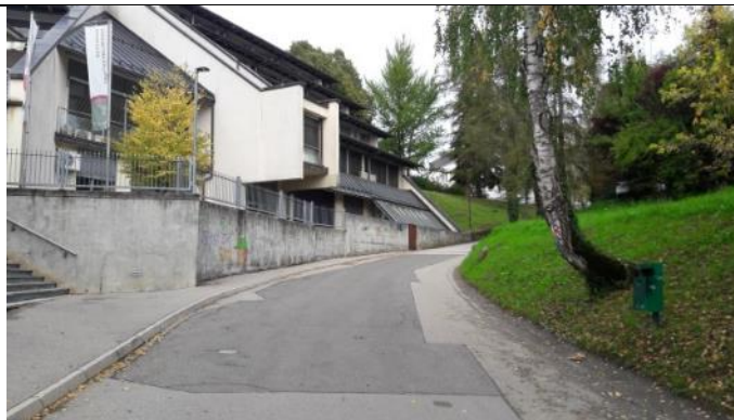
Slika 6: Lokacija predvidenega uvoza (vkop v travnato brežino na desno) v garažno hišo pod Upravno enoto (foto: Kovač. M. 6.10.2017)
