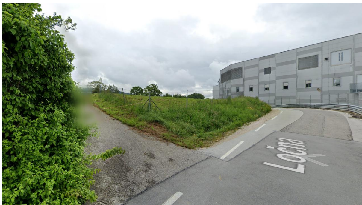
Slika 5: Pogled proti jugovzhodnemu delu obravnavanega območja (levo) in proti območju obstoječih objektov v gospodarski coni (desno). (vir: google street view, februar 2026)
