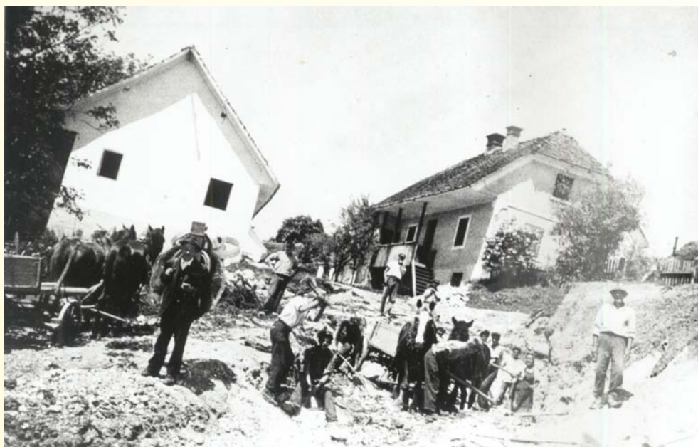
Gradnja ceste do mostu v Otočcu, leto 1954. Foto: Jože Klevišar. Hrani ZVKDS.
