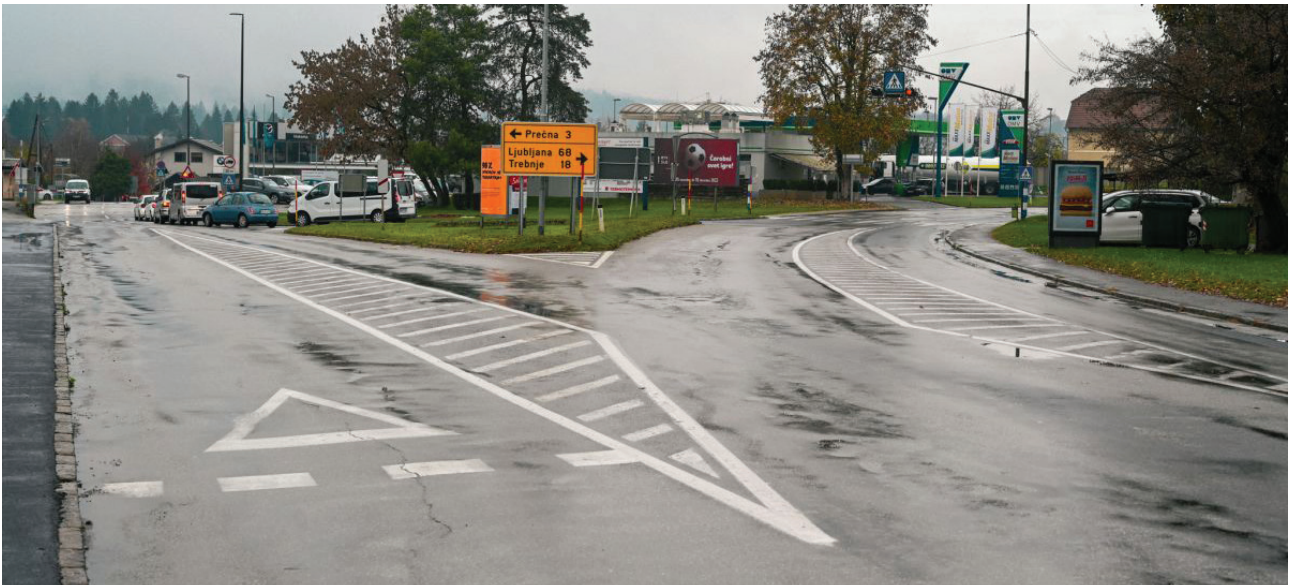
Slika 41 ; Območje križišča Foersterjeve ulice in Ljubljanske ceste, kjer se bo uredilo izvennivojsko križanje ceste z železniško progo (v okviru projekta »Podvoz Bršljin«).
