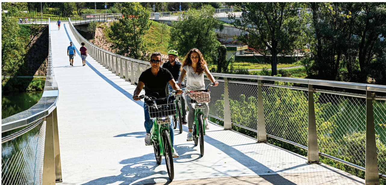
Slika 13 ; Primer dobre prakse – vzpostavljene brvi čez reko Krka za pešce in kolesarje (na sliki Štukljeva brv).
