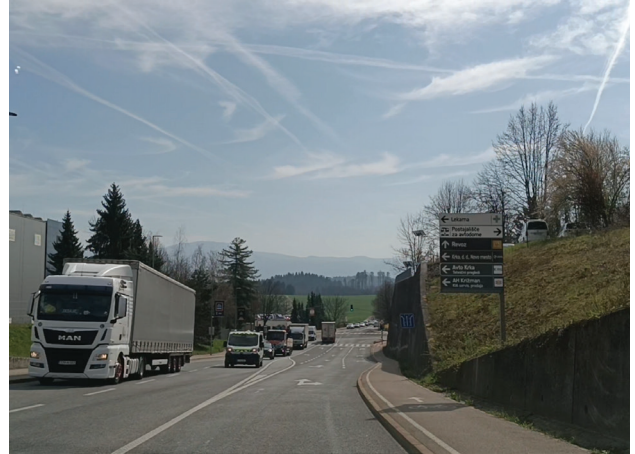
Slika 22 ; Do prometnega razbremenjevanja glavne ceste G2-105, ki letno na odseku med krožnim križiščem »Tabletka« in AC priključkom Novo mesto vzhod beleži okrog 20.000 vozil/dan, z izgradnjo novih obvoznih povezovalnih cest mimo mesta Novo mesto.
