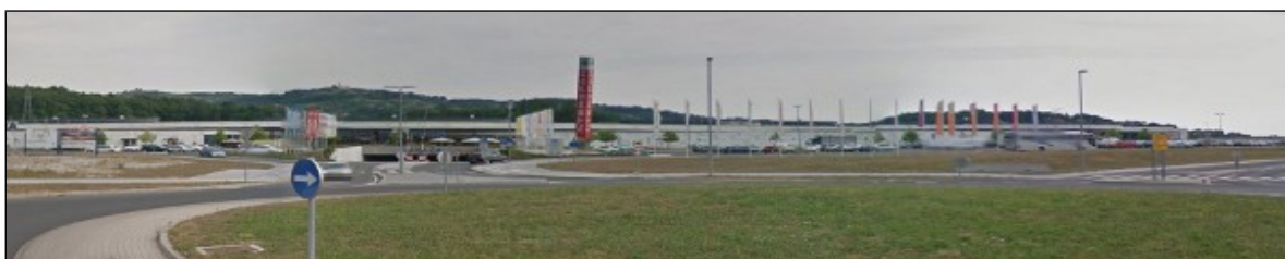
Dostop na območje trgovskega kompleksa Qlandia – krožno križišče K2a
