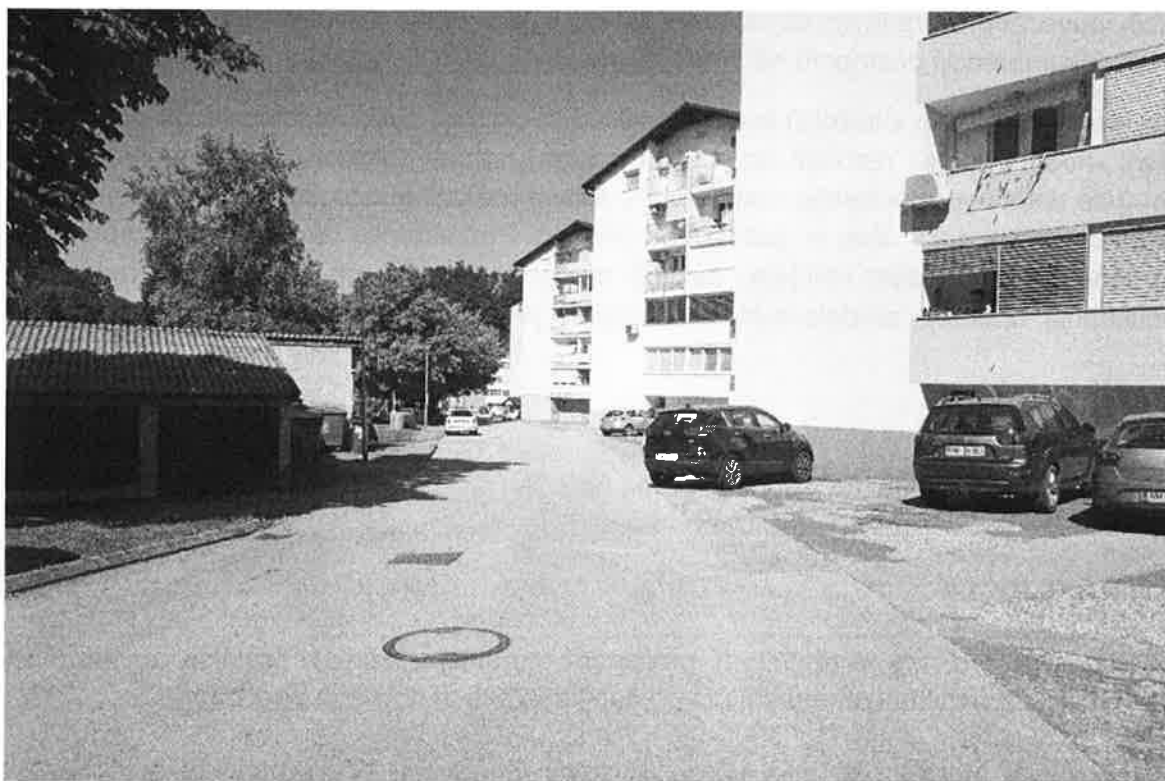
Slika 3: obstoječe stanje ulice Mestne njive (LZ 299111)
