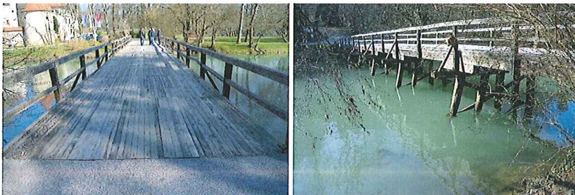
Slika 1.1. Most Otočec v dolžini 37 m: a) pogled na vozišče, pogled na podporno in prekladno konstrukcijo iz smeri dolvodno.
