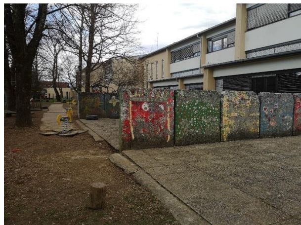
Slika 25: Pogled na igrišče za najmlajše z dotrajanimi prostorskimi elementi in igrali ter neustreznimi talnimi površinami
