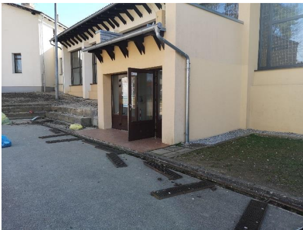
Slika 20: Pogled na vhod v telovadnico iz roketnega igrišča
