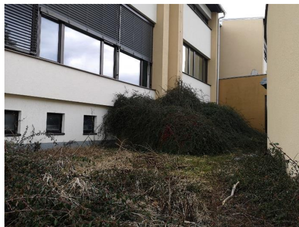
Slika 27: Pogled na preraščen in neurejen atrij med lamelama šolske stavbe
