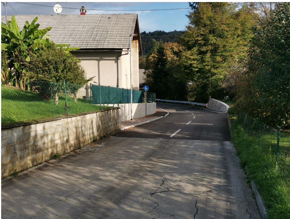
Zaključek obravnavanega območja na 0,60 km in začetek zaključene rekonstrukcije LC 295021 – Dolenje Kamence in Potočna vas.
