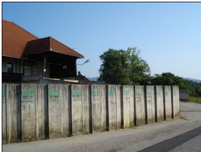
- betonski zid ob lokalni cesti -
