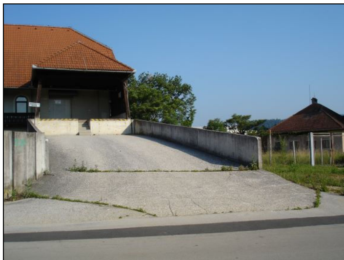
- dovozna rampa od objekta do lokalne ceste -
