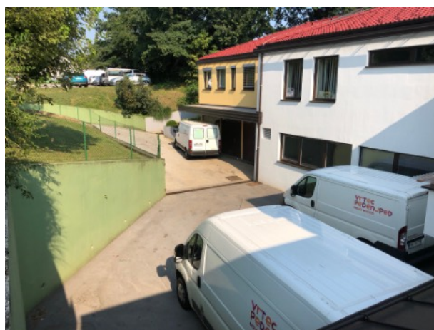
Slika 5: Oporni zid z dostopno klančino
