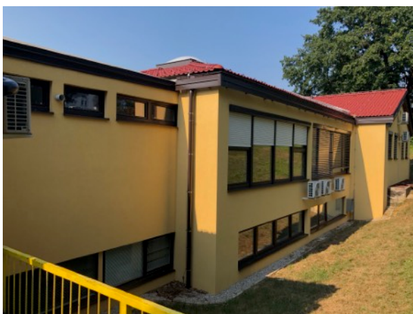
Slika 6: Pogled na južno fasado
